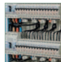
Contrôle de la protection électrique
